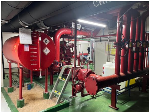
ระบบน้ำสำรอง และ Fire Pump
